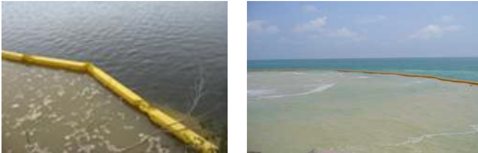
Gambar10. Contoh penggunaan Silt Protector untuk membatasi atau menghalangi pergerakan partikel halus pada saat dilakukan pengerukan atau penimbunan.
